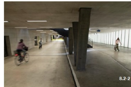
Bahnhofunterführung in Oerlikon mit getrennter Fuss- und Veloführung reduziert die Konflikte zwischen Gehenden und Velofahrenden.
